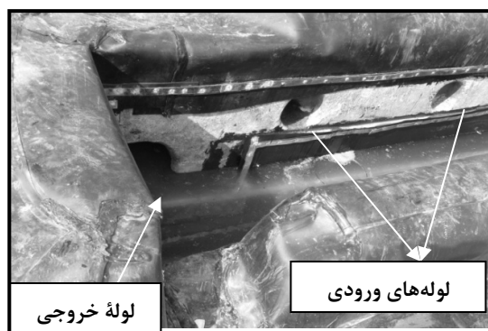
شکل ۲- حوضچه کف استخر و موقعیت لوله‌های ورودی و لوله خروجی در آن بعد از پوشش.
